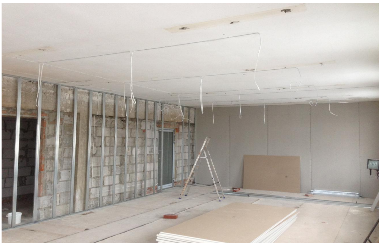
Fot. Remontowane pomieszczenia w ramach programu „Bezpieczna+”.
