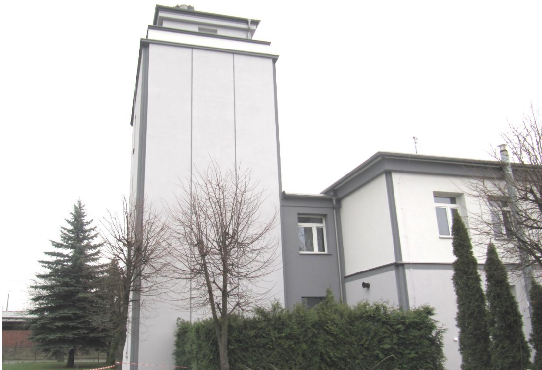
Fot. Termomodernizacja budynków KM PSP w Siedlcach - JRG nr 2.
