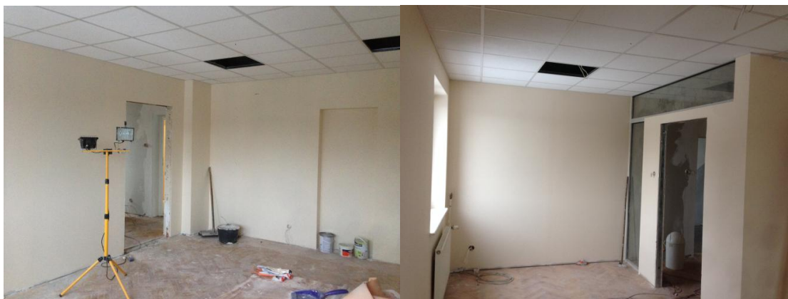
Fot. Remontowane pomieszczenia biurowe.
