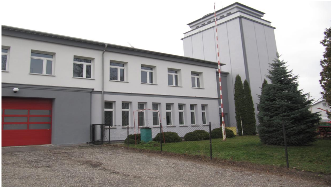
Fot. Termomodernizacja budynków KM PSP w Siedlcach - JRG nr 2.
