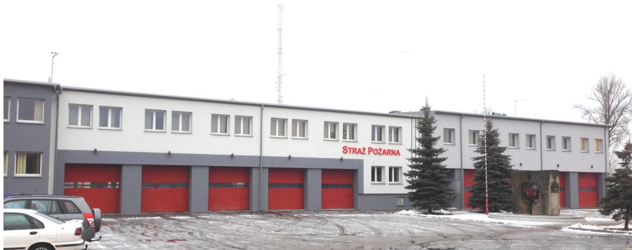
Fot. Termomodernizacja budynków KM PSP w Siedlcach.
